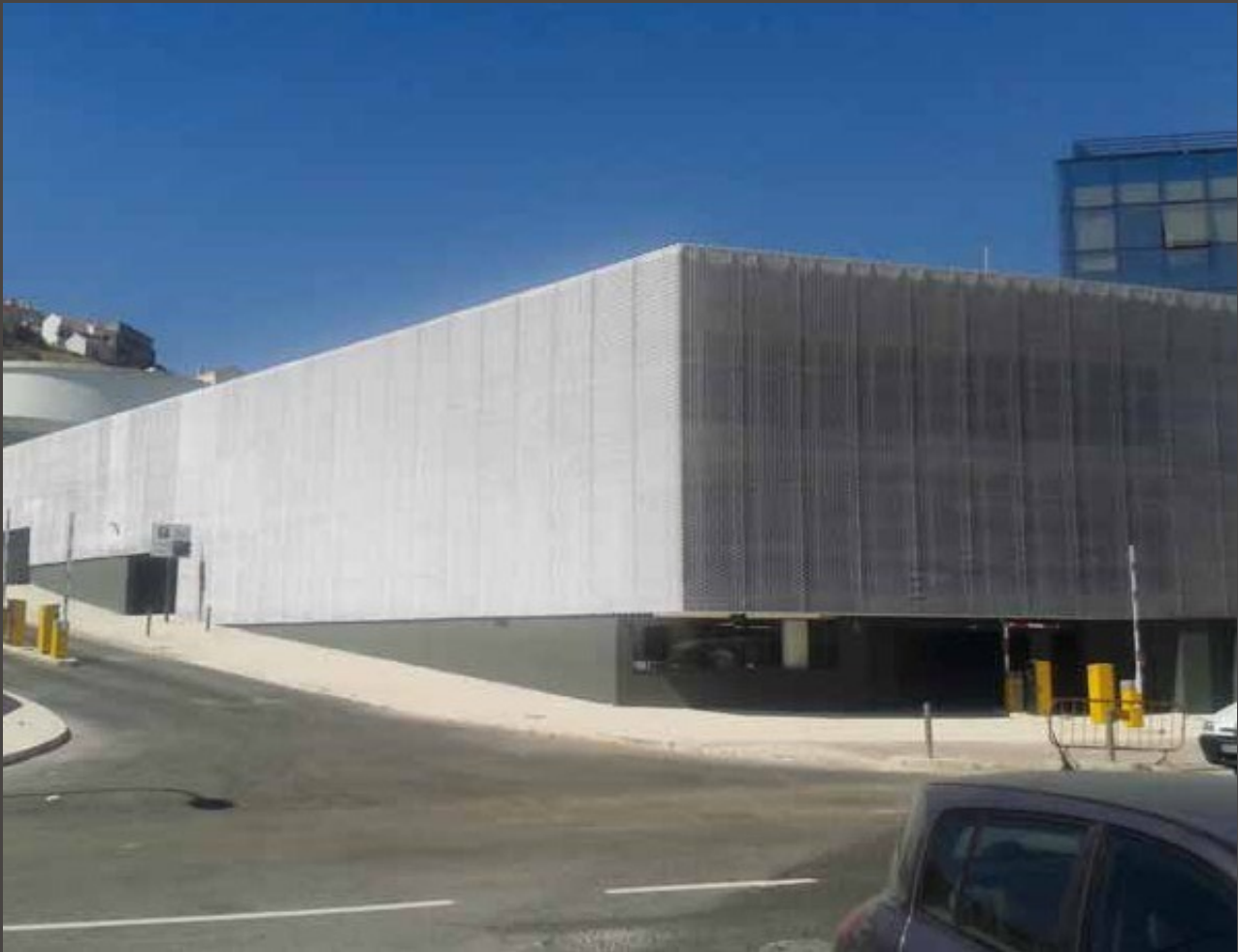
پوسته سازی نمای ساختمان اداری پرتغال VENTILATED FACADE, ÁGUAS E SANEAMENTO DE OEIRAS E AMADORA - PORTUGAL
